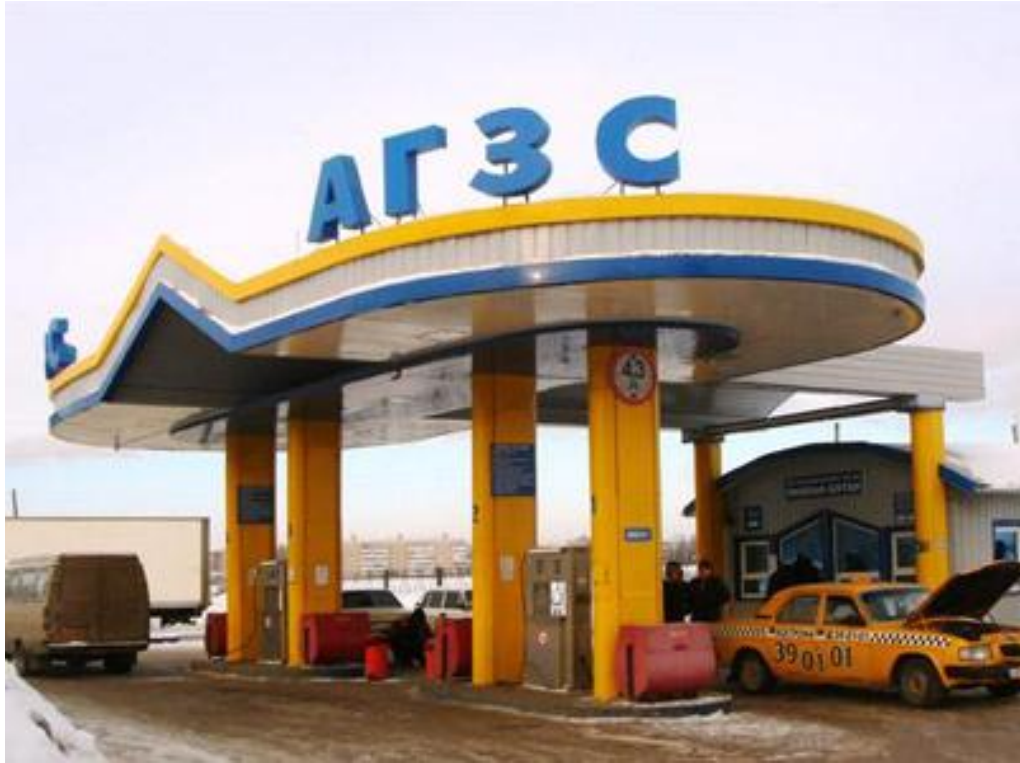
Рисунок 1. Автомобильная газозаправочная станция
