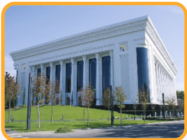
Строительство дворца международных Форумов Uzbekistan Congress Hall Узбекистан, г. Ташкент, ул. Истикбол, 1
